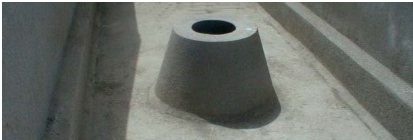
Esperas (crujías) para instalaciones típicas en concreto, suplidas por el cliente
