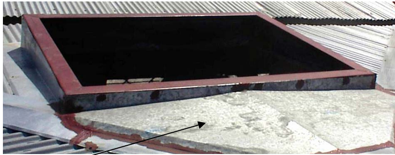
Crujía en techo de zinc, suplida por el cliente
